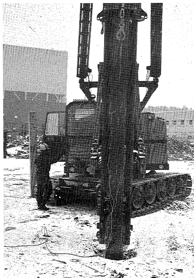
Stötvågsmätning med stålknekt på påle 235 \times 235 \text{ mm}^2 .
